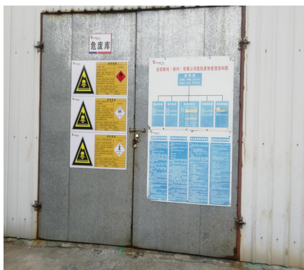
危险废物堆放间
