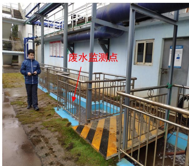
污水处理站外排口
