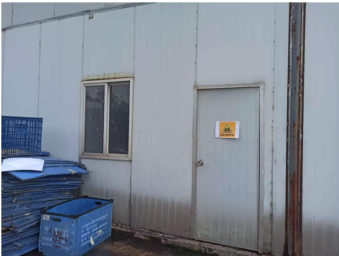
危险废物暂存间
