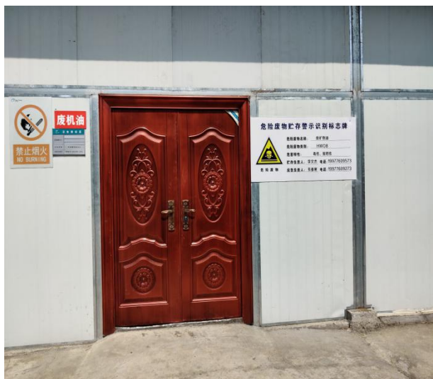
危险废物堆放间
